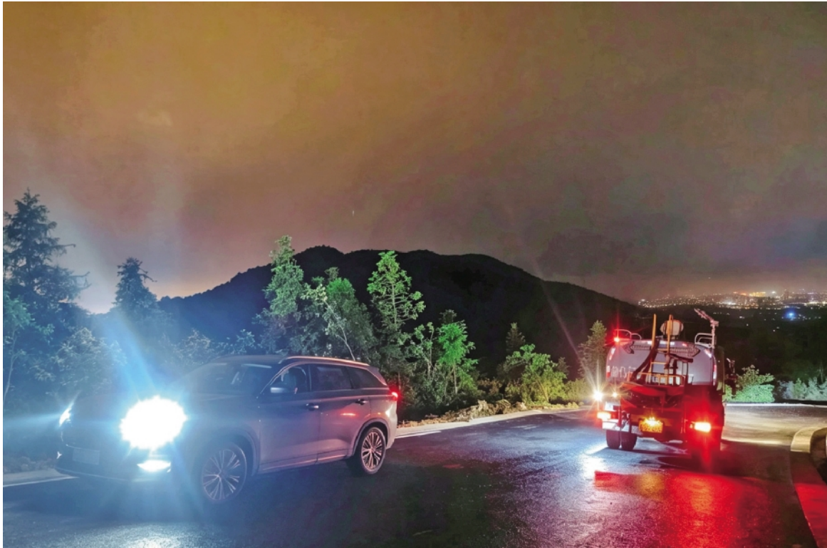
6 月 15 日,施工单位对缙云路网云坊路路面进行清洗。周丽 摄
