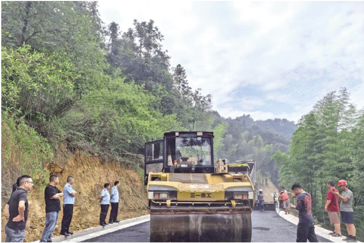
6 月 4 日,缙云山璧山片区(璧城水天池至青杠白云湖)路网改造工程施工现场。郭浩 摄
