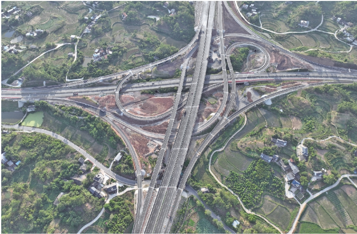
2024 年 9 月 13 日建成通车的渝(重庆)遂(遂宁)复线公路(经璧山区)
