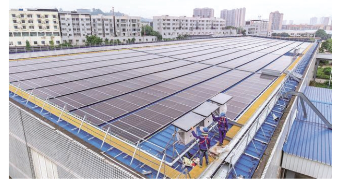
恒力化工有限公司分布式光伏发电项目建设现场
