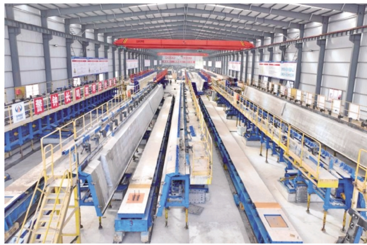
智慧梁场移动台座与固定开合液压模板协同系统
