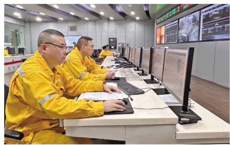
华润电力重庆能源集团川渝电力分公司松藻电力发电部发电运行员工精心监护发电设备运行
