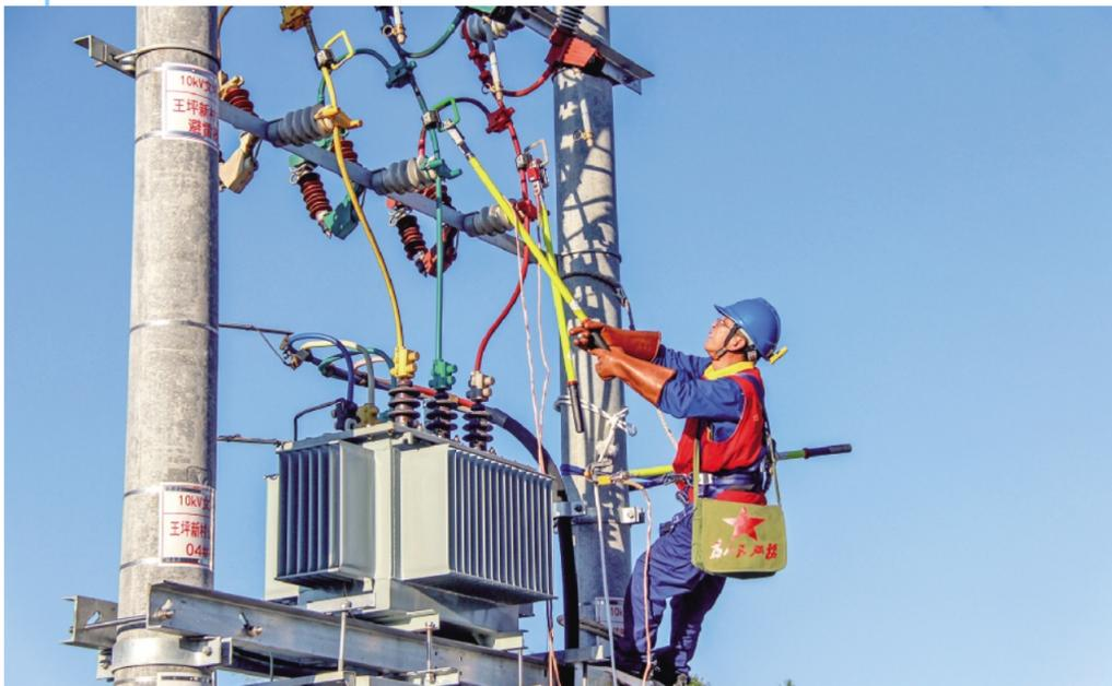
近日,巴中市通江县沙溪镇王坪村,国网通江县电力公司施工人员正在处理10千伏文坪线王坪新村公变低压柜头C相发热缺陷,为辖区用户提供坚强的电力保障。
