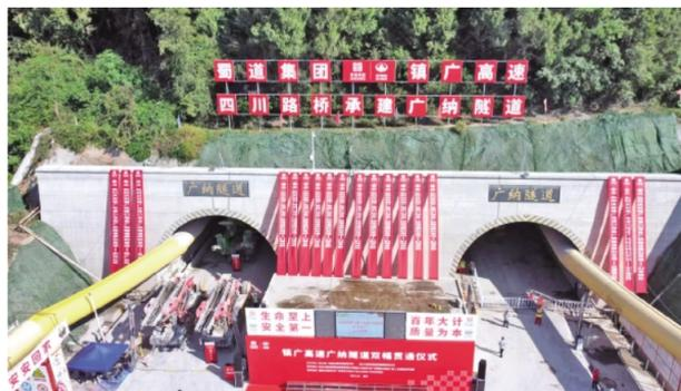
值:0.25%);引进安全智慧用电装置,有效防止漏电伤人,保护隧道施工用电设备安全;三臂拱架台车、双曲臂岩台车、自动布料二衬台车等设备代替传统人工作业,机械化施工率达到100%,累计减少人工60%,施工总效率提升30%。
