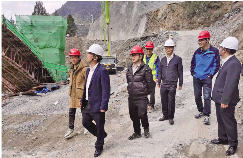
公司领导到大渡河项目部的帕尔巴大桥进行安全巡查
